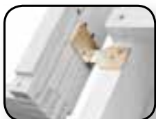
Montaż na krokwiach
